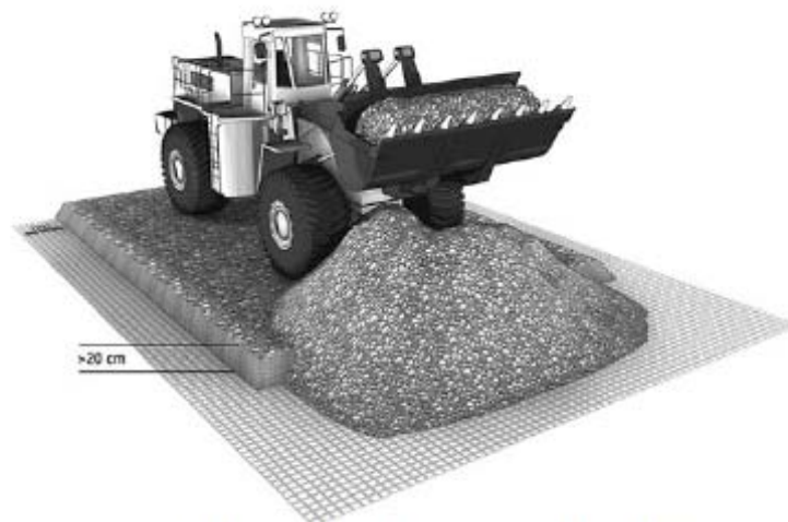
Abb. 6: Einbringen von Schüttmaterial auf Secugrid®
